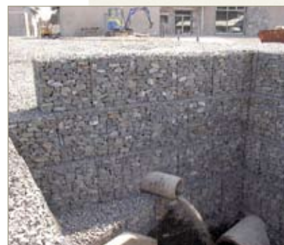
Gabions kā neatņemama drenāžas sistēmas sastāvdaļa. Uzcelts Ziemeļirijā 2002.gadā
