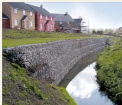
Balsta siena ar aizsardzību pret eroziju domātu ieklājumu, Bristolē, Anglijā. Uzcelta 2004.gadā.
