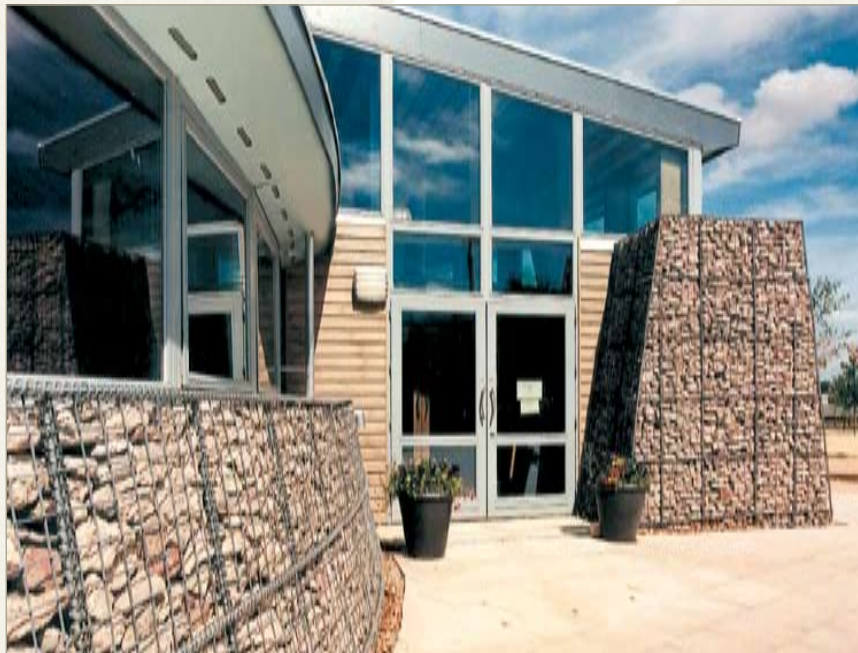
Zemes centrs, Anglija. Videi draudzīga būve, kuras celtniecībā ir izmantotas visas Trapion™ sienu priekšrocības ar vienvēidīgi pārejošu sasmalcinātu betona pildījumu. Uzcelts 2000.gadā.
