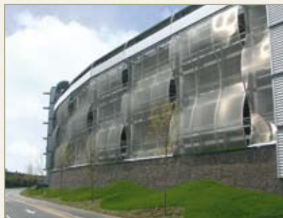
Brīvi stāvošs Trapions™ nosedz daudzstāvu automašīnu stāvlaukumu. Clarence Dock, Leeds, Anglija. Uzcelts 2004.gadā.
