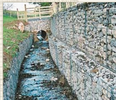
Kanāla stiprinājumi, kas ir uzcelti izmantojot gabionus un ieklājumus. Graigfechan, Velsa. Uzcelts 2000.gadā.
