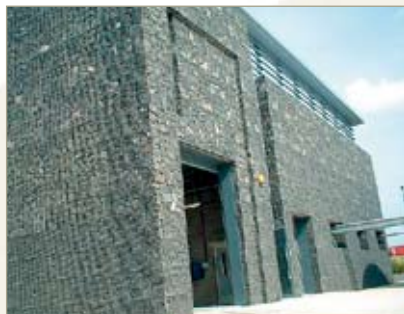
Arhitektūras greznošanas darbi Duncrue gāzes mazgāšanas ierīces ūdens padeves ēkā, Belfasta, Ziemeļīrija. Uzcelts 2004.gadā.
