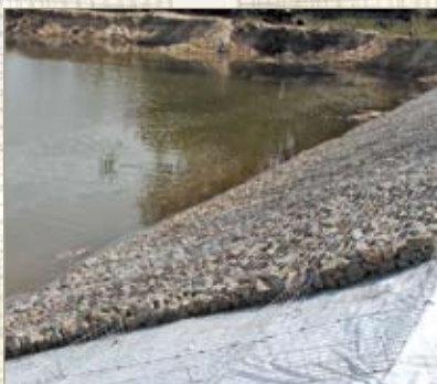
Piekrastu aizsardzība, izmantojot Weldmesh® (metināta tīkla) ieklājumus. Czeszow, Polija. Uzcelts 2005.gadā.
