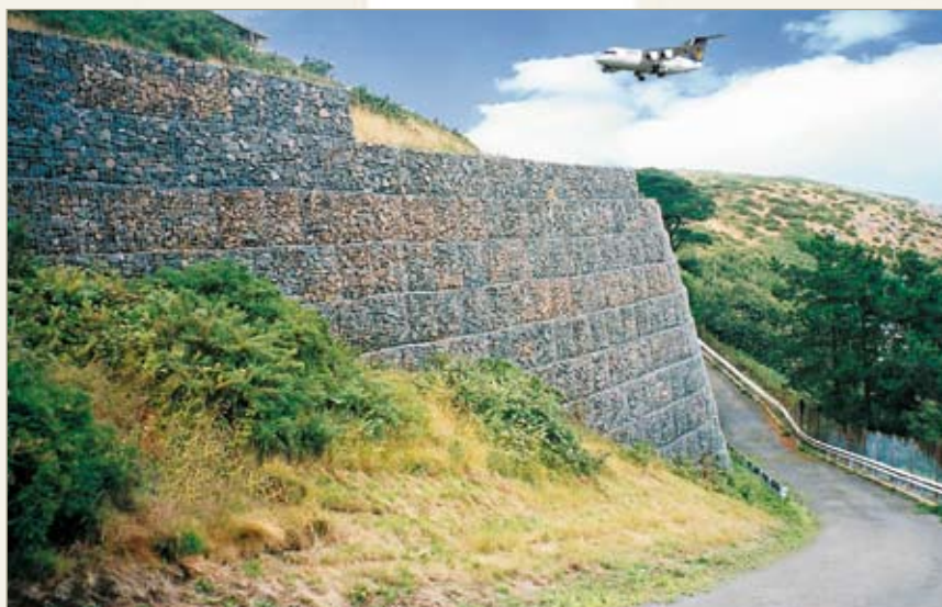
Liela gabionu siena – 19 m augsta, ir uzcelta 1968.gadā, lai nostiprinātu Jersey lidostu Lamanša salās.
