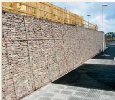
Mazumtirdzniecības parka būve – balsta siena.
