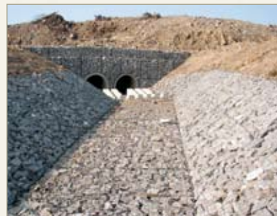
Ūdenscaurlaidības stiprinājumi, pielietojot ieklājumus. Uzstādīti pie A465 ceļa („Heads of the Valley Road”), Dienvidvelsa. Uzcelts 2004.g.
